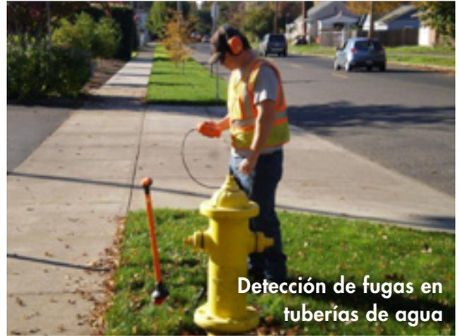
Detección de fugas en tuberías de agua
