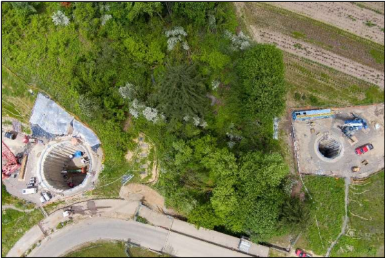
Instalaciones de agua cruda en el río Willamette
