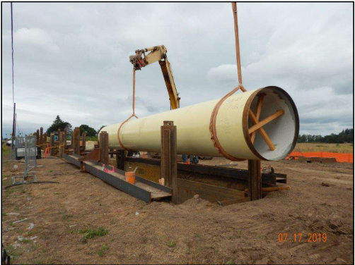
Proyecto de tuberías en Scholls Ferry Road (Beaverton)
