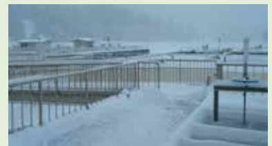
La Planta de Tratamiento de Agua de la Comisión Conjunta del Agua.
